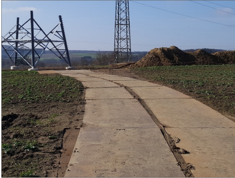
Abbildung 2: Temporäre Baustellenzuwegung über Lastverteilerplatten (Quelle: Amprion GmbH)
