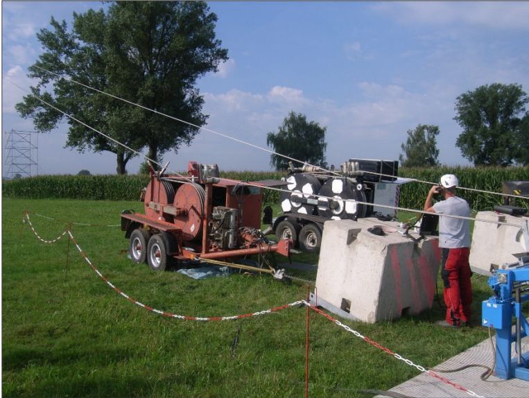
Abbildung 6: Wundenplatz beim Seilzug (Quelle: Amprion GmbH)
