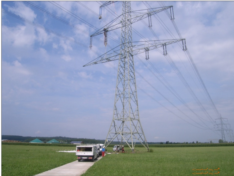
Abbildung 3: Temporäre Arbeitsfläche zur Umbeseilung (hier: für einen Stromkreis) (Quelle: Amprion GmbH)
