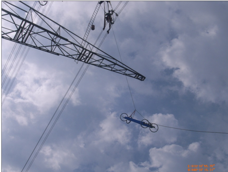
Abbildung 4: Austausch der Isolatorketten (Quelle: Amprion GmbH)
