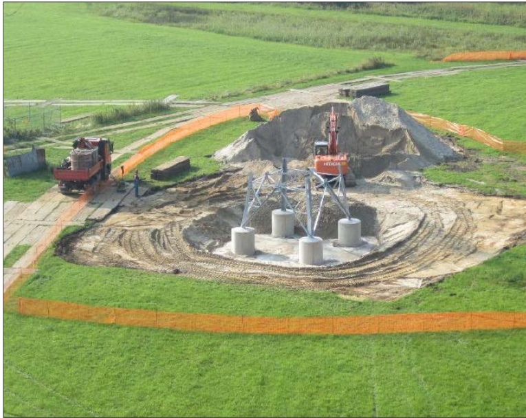
Abbildung 9: Gründung eines Plattenfundaments (Quelle: Amprion GmbH)
