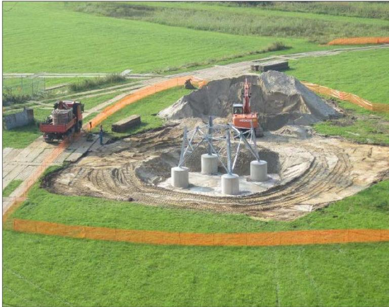
Abbildung 9: Gründung eines Plattenfundaments (Quelle: Amprion GmbH)
