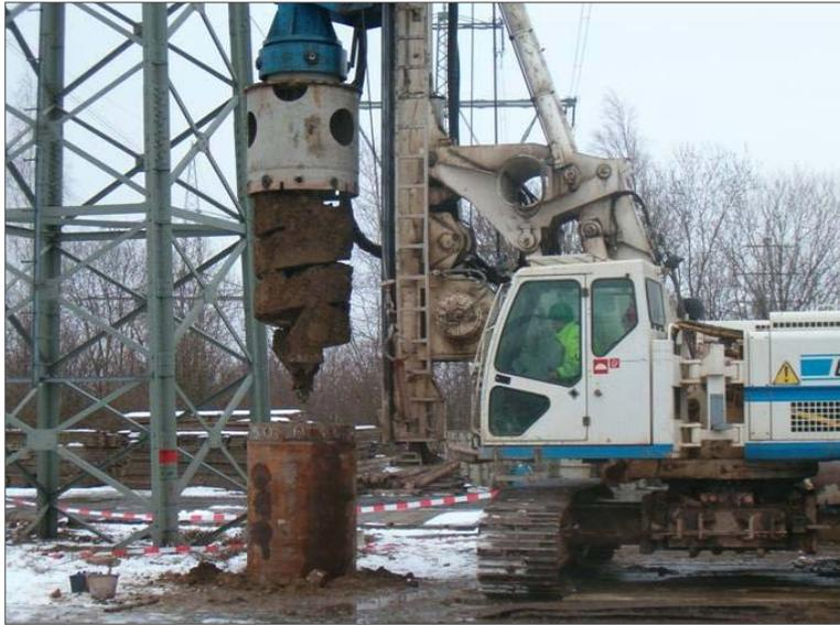
Abbildung 10: Bohrung für eine Bohrpfahl (Quelle: Amprion GmbH)
