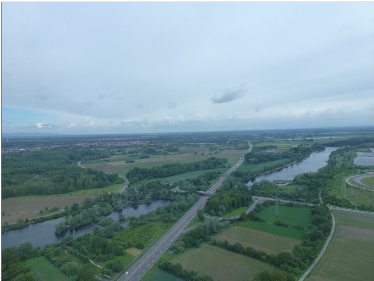
Abbildung 1 Abschnitt der Leitungstrasse zwischen Mast 163 und 164 der Leitung Bl. 4567
