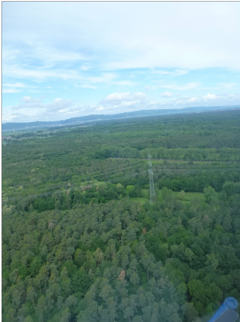
Abbildung 1 Detailliert untersuchter Bereich im Umfeld von Mast 35 der Leitung Bl. 4567
