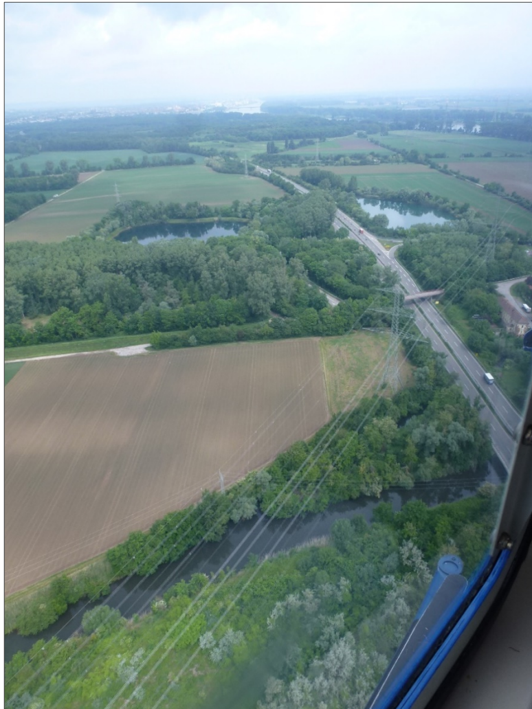
Abbildung 1 Abschnitt der Leitungstrasse zwischen Mast 13 und 14 der Leitung Bl. 4542
