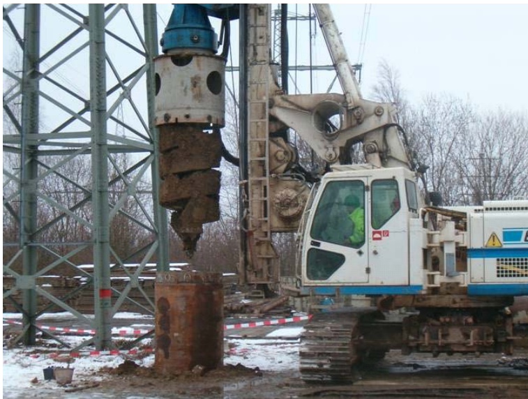
Abbildung 2 Bohrung für eine Bohrpfahl
