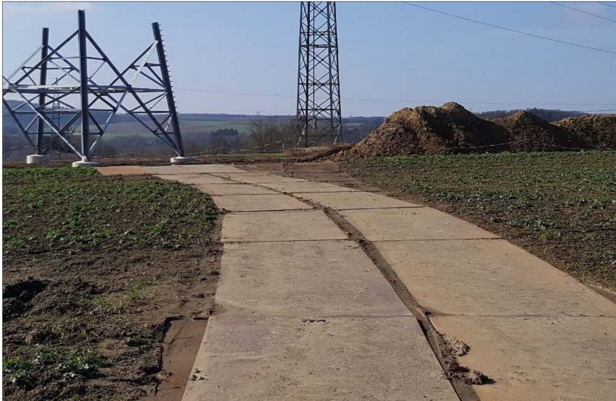
Abbildung 3 Temporäre Zuwegung über Stahlplatten
