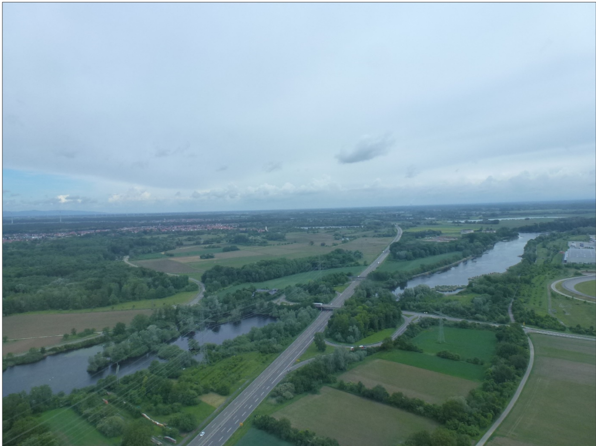
Abbildung 1 Detailliert untersuchter Bereich im Umfeld von Mast 163 der Leitung Bl. 4567
