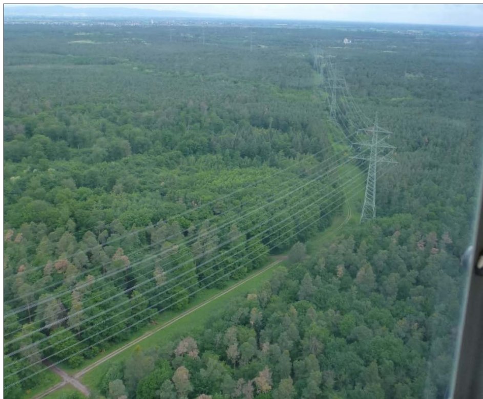
Abbildung 1 Detailliert untersuchter Bereich im Umfeld von Mast 66 Richtung Süden entlang der Leitung Bl. 4567
