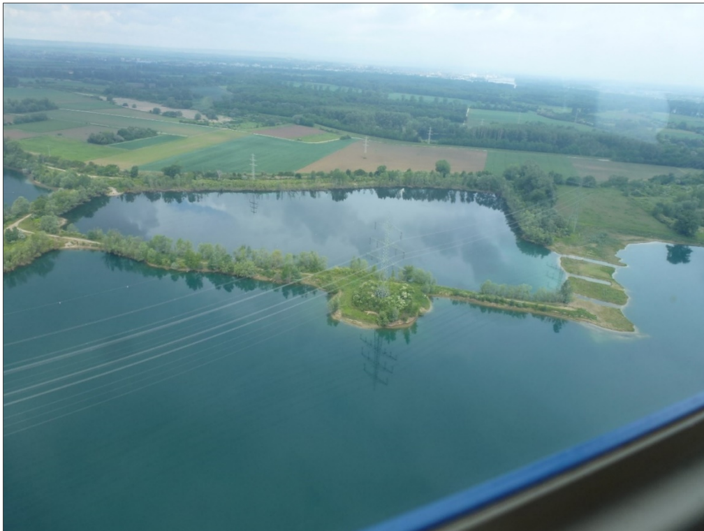
Abbildung 1 Detailliert untersuchter Bereich im Umfeld von Mast 16 der Leitung Bl. 4542
