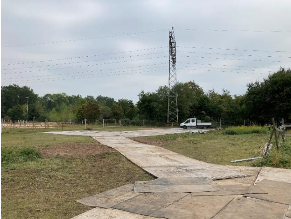
Abbildung 6: Sicherungsmaßnahmen auf temporär benutzten Zufahrten und Arbeitsflächen durch Panels
