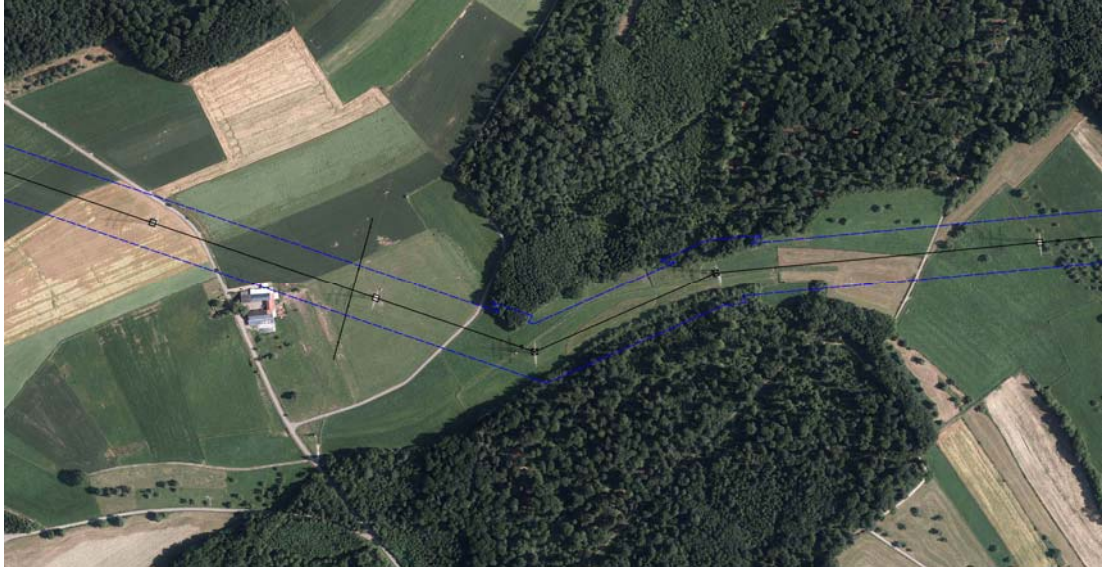
Abbildung 15: vorhandene Trasse der 220-kV-Höchstspannungsfreileitung Bl. 2409 bei Hofgarten
