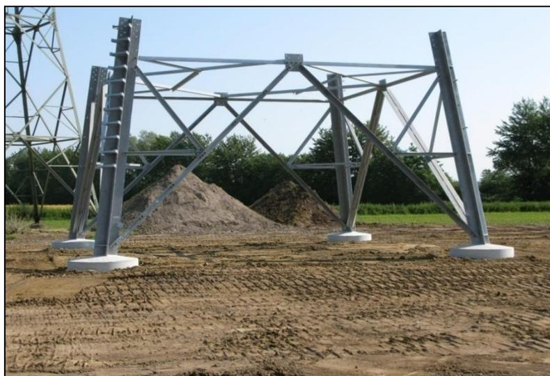
**Abb. 41: Montierter Mastfuß**
