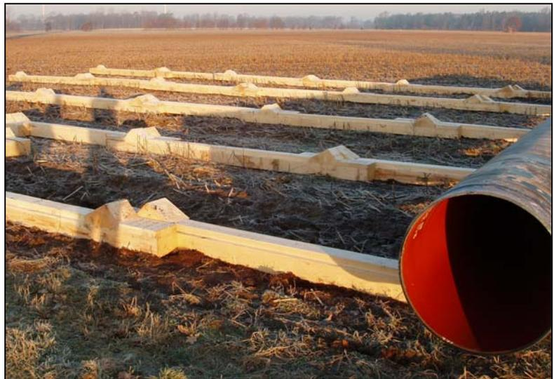
**Abbildung 2: Holzbalcken zum Lagern der Rohre**
