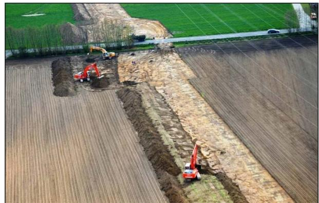
**Abbildung 15: Abheben und lagern des Mutterbodens**
