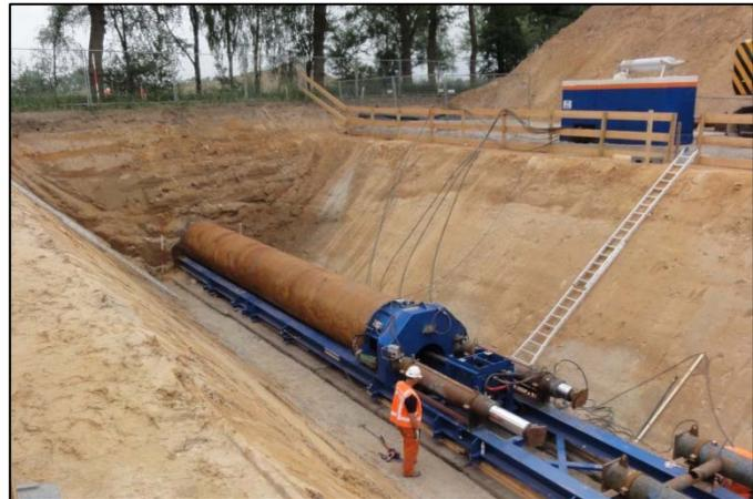
**Abbildung 21: Baugrube mit Pressgerät / -schlitten**
