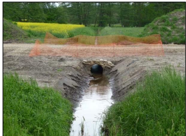
**Abbildung 22: Überfahrt über einen wasserführenden Graben**
