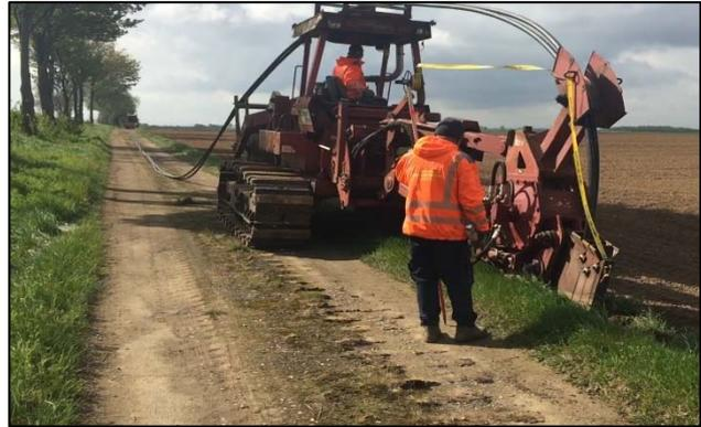
**Abbildung 24: Kabelpflug mit Raupe als Zugfahrzeug**
