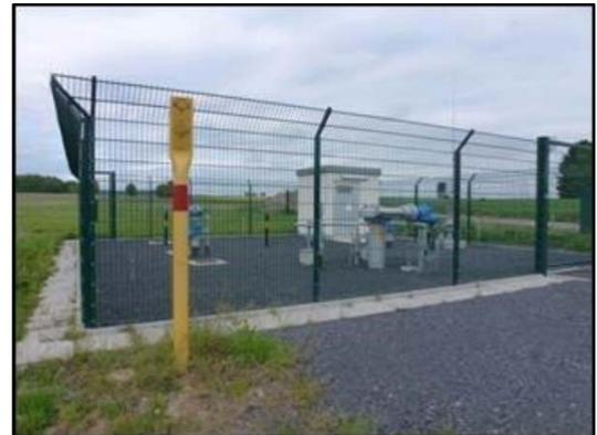
**Abbildung 12: Beispielbild einer Armaturenstation mit Übersteigschutz und Technikcontainer**
