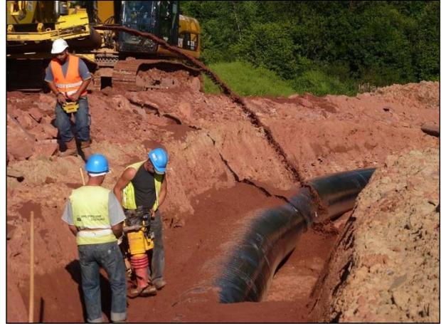
**Abbildung 19: Verfüllen des Rohrgrabens**
