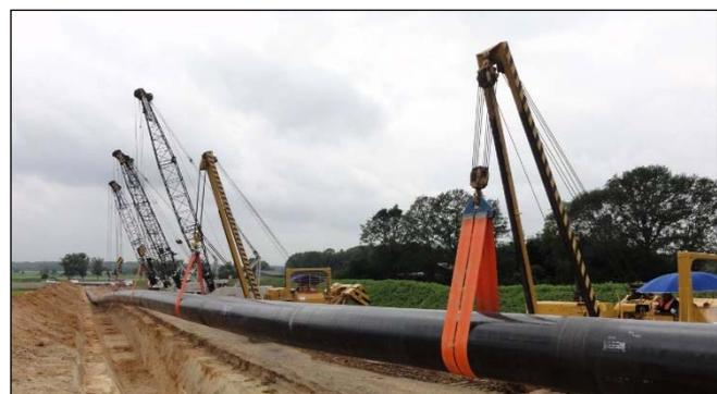
**Abbildung 18: Absenken des Rohrstranges mit Seitenbäumen / Rohrlegern und hier im Hintergrund auch Seilbaggern**
