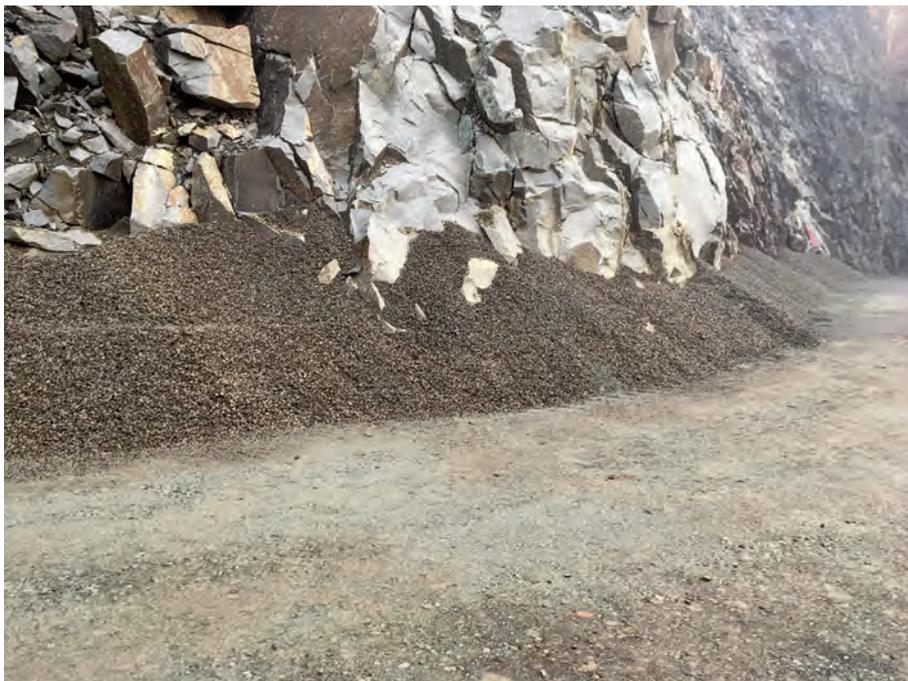
Abb. 4: Drän- und Ausgleichsschicht an der Steilwand.
