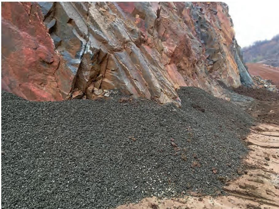
Abb.6: Folgelage der Drän- und Ausgleichsschicht an der Steilwand.
