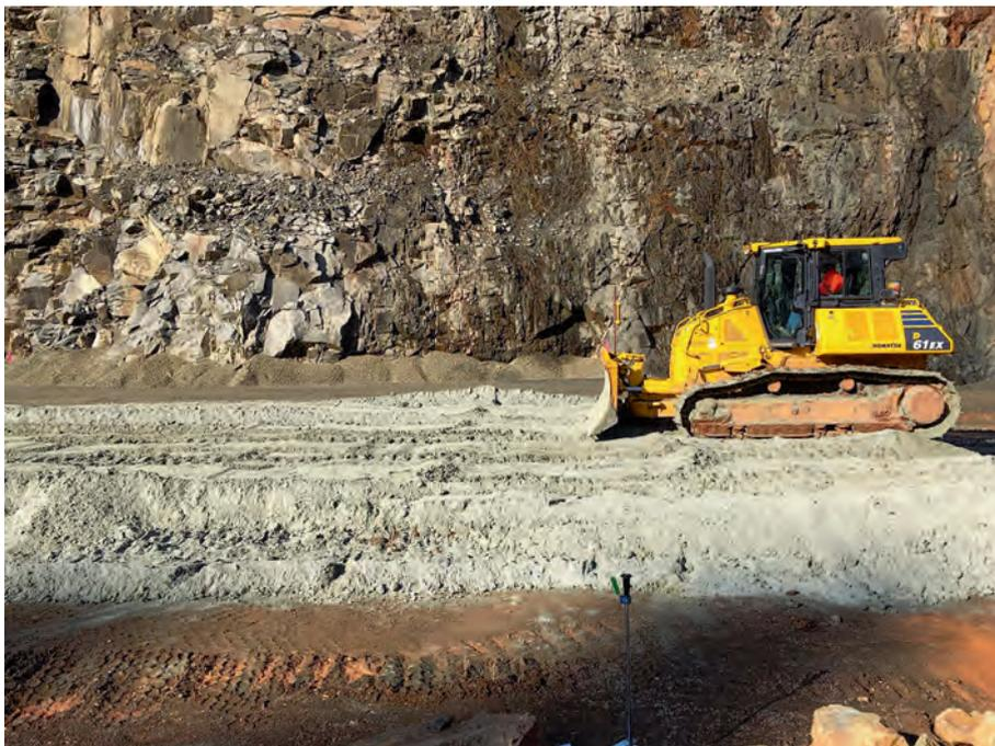
Abb. 2: Einschleppen des Gesteinsmehls (geol. Barriere) mittels Raupen.
