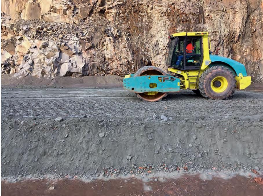
Abb. 3: Verdichtung des Gesteinsmehls (geol. Barriere) mittels Schafffußwalze.
