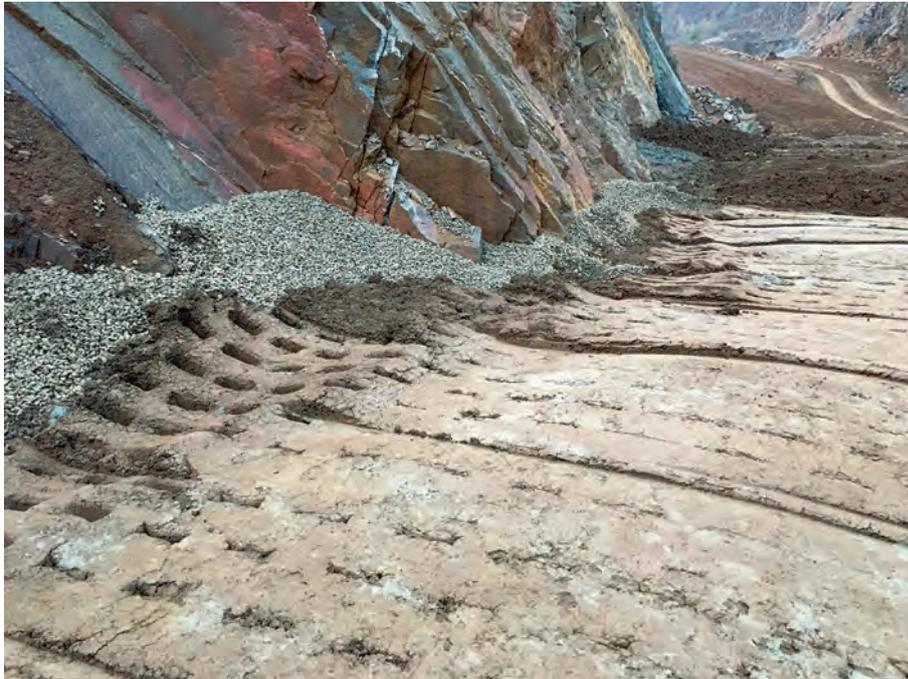
Abb. 5: Drän- und Ausgleichsschicht an der Steilwand; davor verdichtete geol. Barriere.
