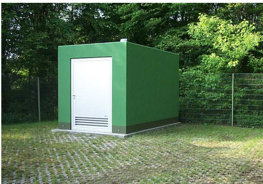
Abbildung 4: Beispielsicht oberirdische Brunnenstube
