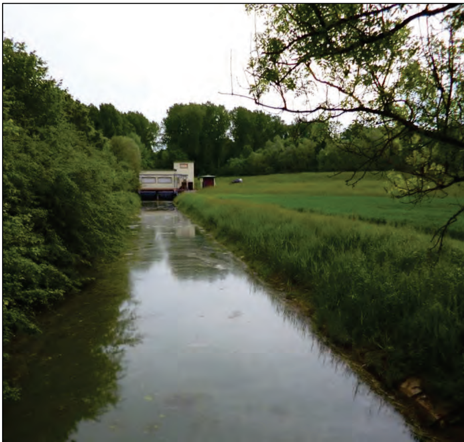
Foto 2-3: Schöpfwerkskanal landseits des Rheinhauptdeichs (Blickrichtung Osten) mit Schöpfwerksgebäude.
