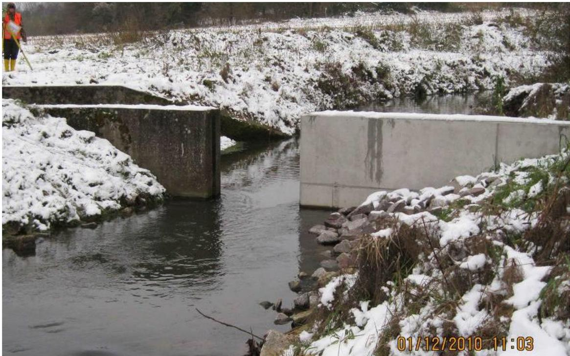
**Abbildung 20: Wattbachdreieck, Dammbalkenverschluss Erlenbach, Foto gegen die Fließrichtung**
