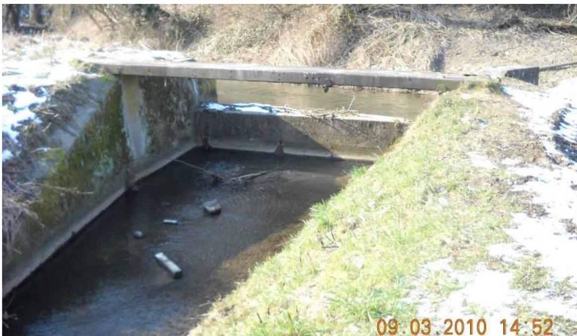
**Abbildung 21: Wattbachdreieck, Streichwehr bzw. Abschlag Wattbach, Foto gegen die Fließrichtung**
