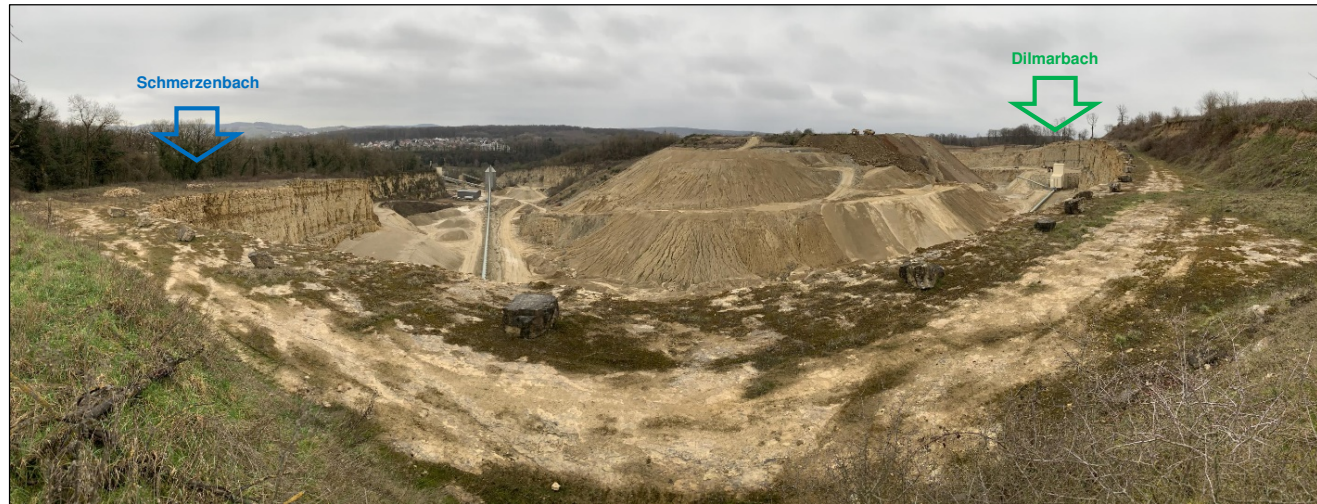
Abb. 2: Panoramaaufnahme (Süden links, Norden rechts) vom derzeitigen östlichen Ende des Abbaubereichs (Aufnahme GWW 02/2021).
