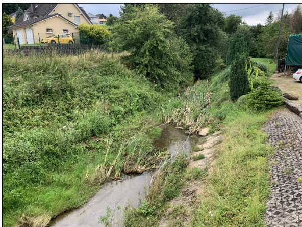
Abb. 14: Blick auf das Bachbett des Dilmarbachs in der Ortslage Dilmar unterhalb der Moselstraße. Zu sehen sind Spuren einer vorübergehend starken Wasserführung nach Niederschlägen (Aufnahme GWW 08/2021).
