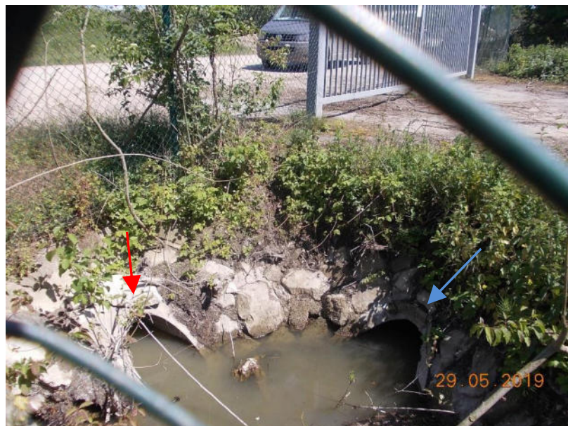
Abbildung 2: Einleitungsstelle E3 Gewässer 1870 (Pfeil rot) und Gewässerverrohrung Gewässer 1870 (Pfeil blau)
