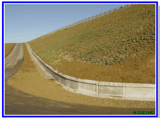
Sofern bei einer späteren Überprüfung des Abb. 9: Amphibienschutzeinrichtung (MAIBACH 2022)
