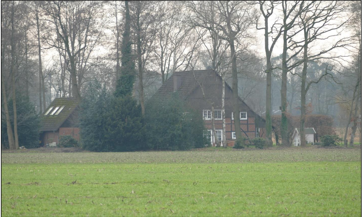
Abbildung 53: Wohnhaus ,Delbrück-Steinhorst, Steinbreite 2' – Fotorichtung Süd
