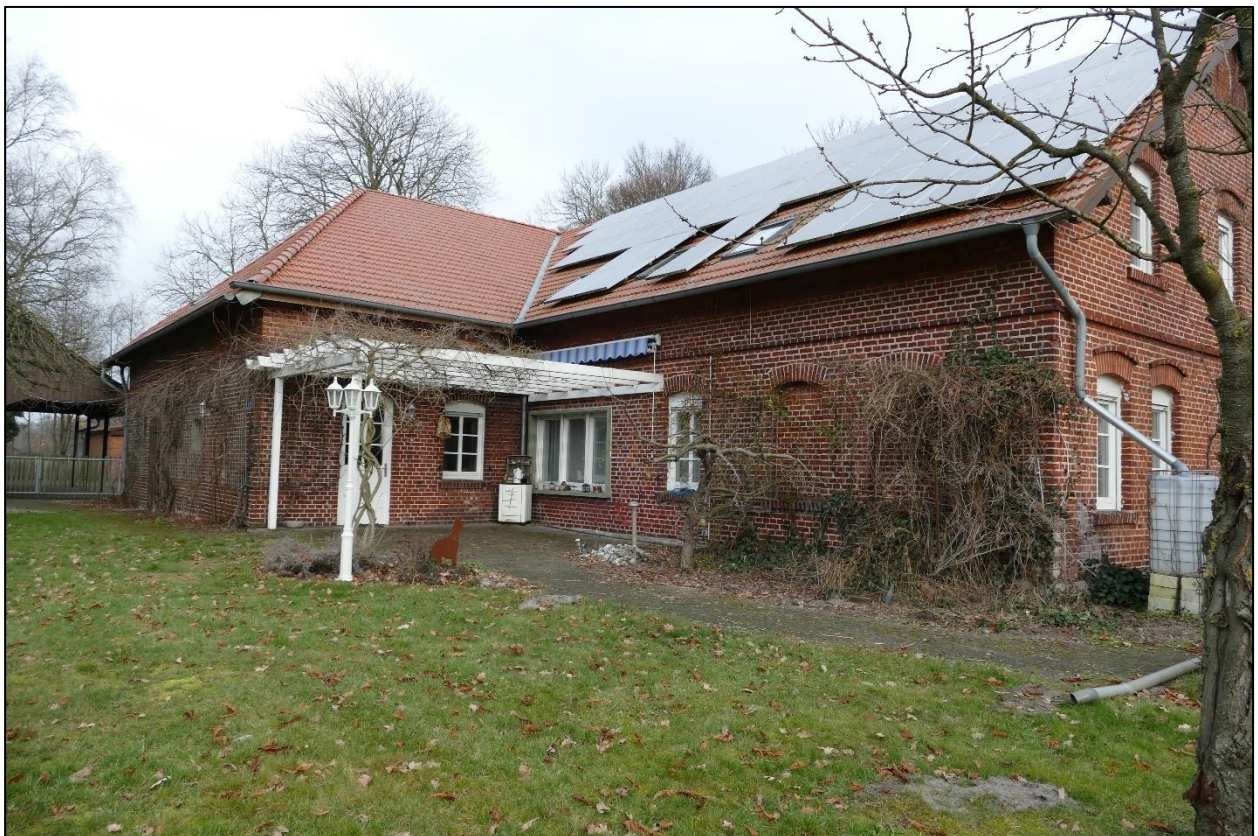
Abbildung 5: Terrasse des Wohnhauses ‚Hövelhof-Espeln, Kaunitzer Straße 33‘ – Foto- richtung Nord
