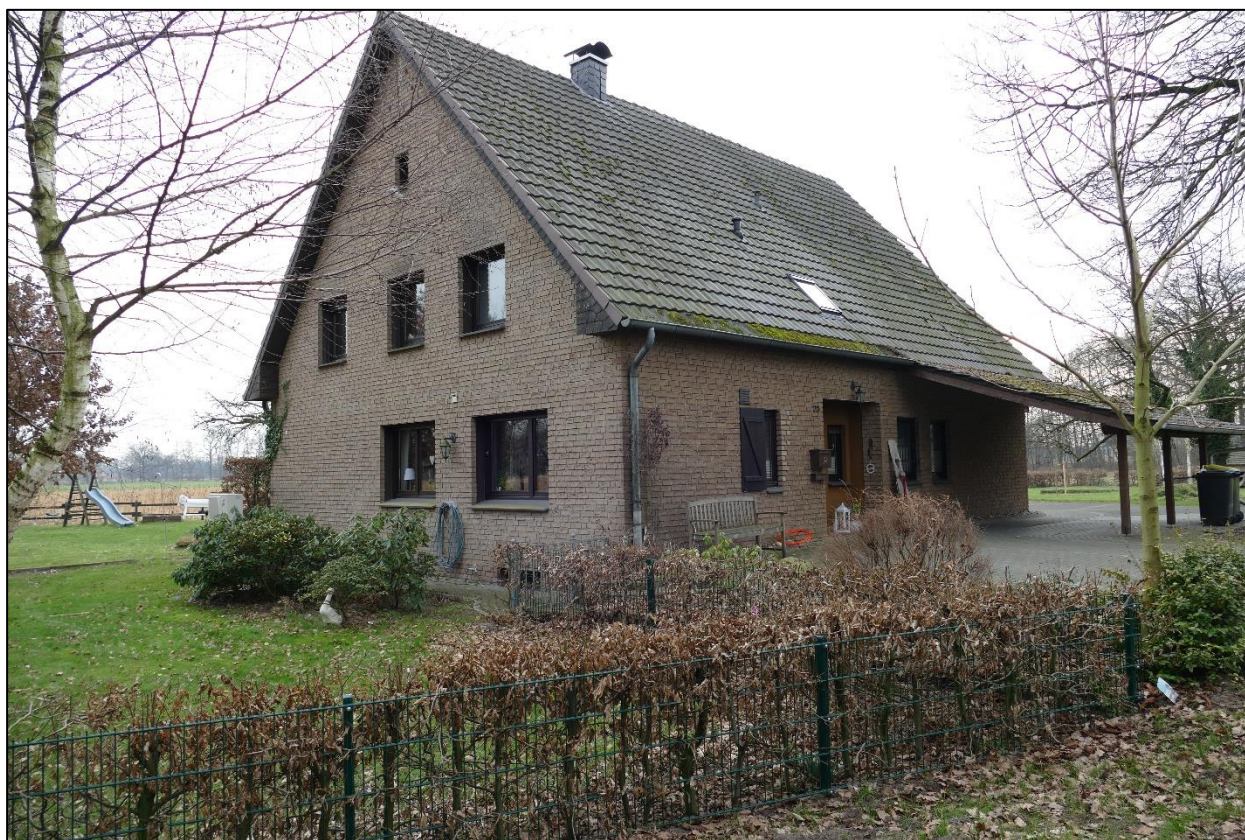
Abbildung 38: Wohnhaus ‚Hövelhof-Espeln, Emsallee 20‘ – Fotorichtung Südost
