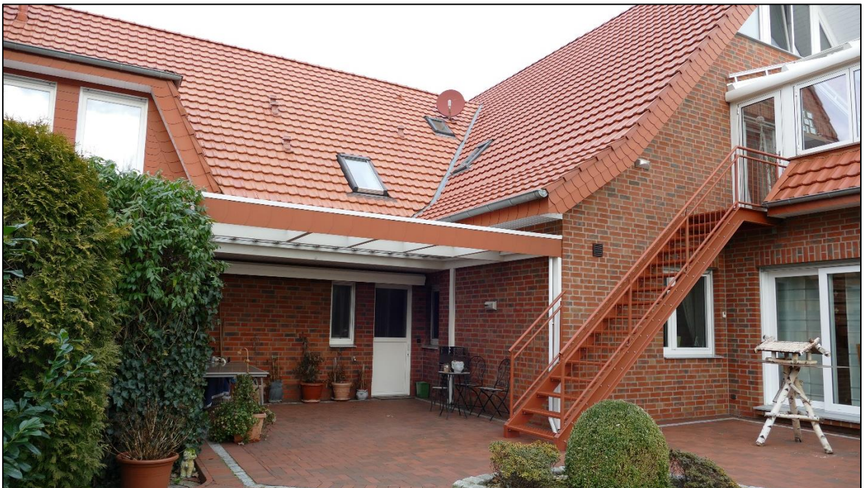
Abbildung 12: überdachte Terrasse – Fotorichtung Nordost
