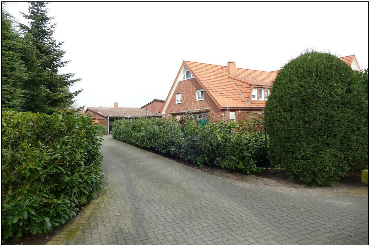
Abbildung 17: Wohnhaus ,Hövelhof-Espeln, Am Furlbach 22 a, b, c‘ – Fotorichtung Nord
