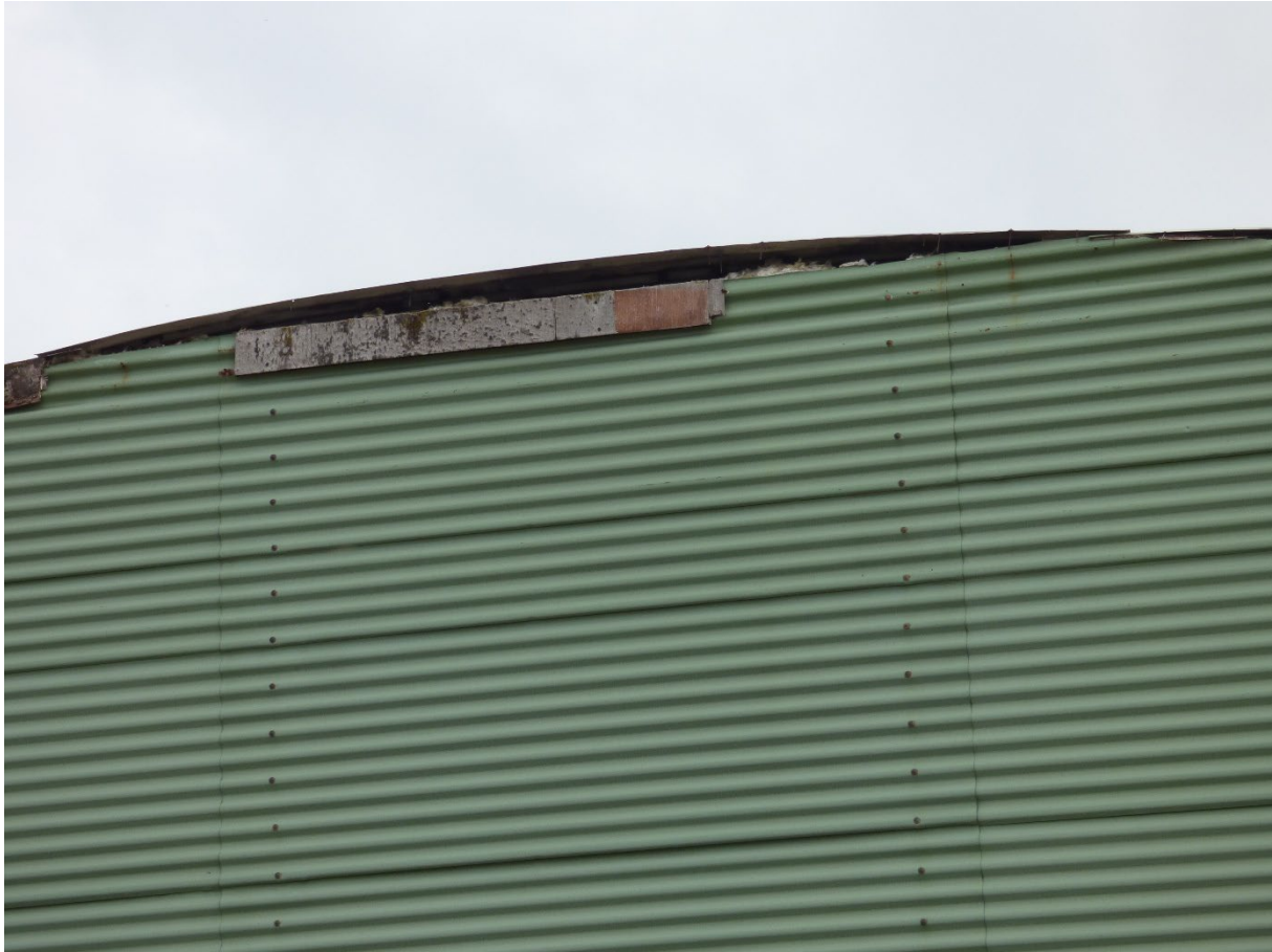
Abbildung 11 Vorhandene Gebäudenischen wie hier im oberen Bereich der Halle sind potenzielle Brutplätze für Arten wie den Hausrotschwanz.
