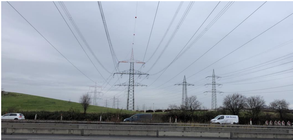
Abbildung 3.13 Ansicht von der BAB 3, Abstand Gelände - Leitungen
