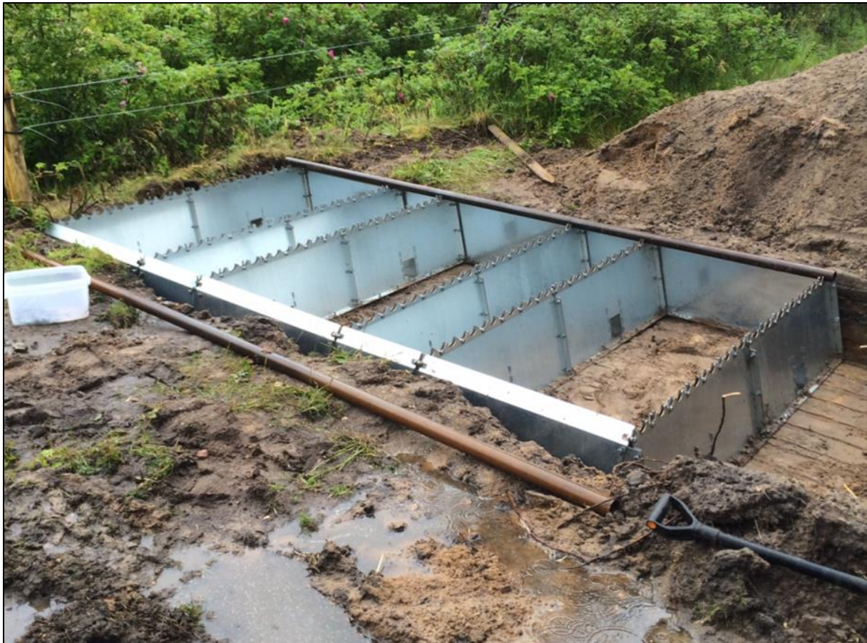
Abbildung 15: Beispiel für die Tragkonstruktion eines Viehgitters /10/
