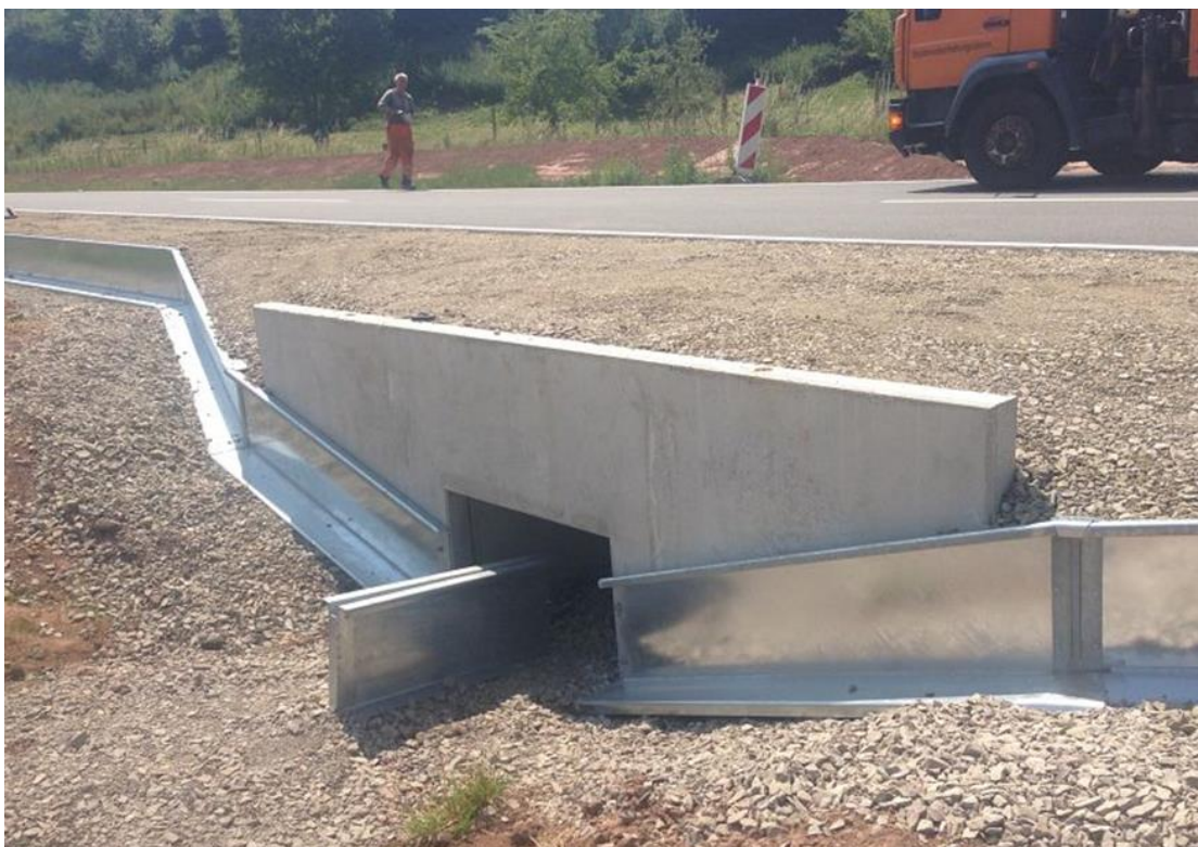
Abbildung 13: Beispiel für einen Kleintierdurchlass unter der Straße /11/
