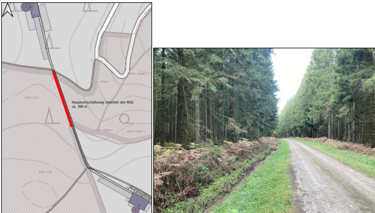
Abb. 4A/B: Durchfahrt zwischen WEA 2 und 3: Wirtschaftsweg mit Randstreifen, Graben und umliegenden Fichtenforsten.
