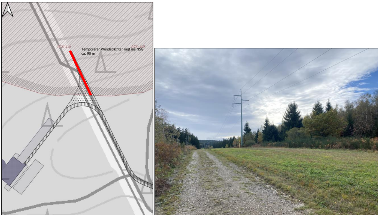
Abb. 5A/B: Bereich des temporären Wendetrichters an WEA 1: Trasse mit Strom- und Gasleitung, sowie Wirtschaftsweg.
