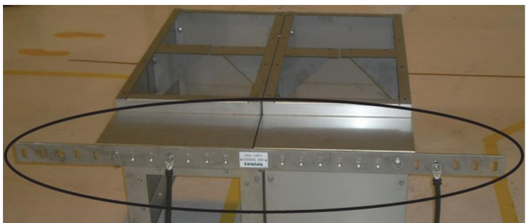
Abbildung 2-4: Auf der Rückseite eines Grundrahmens mit zwei Konsolen montierte Haupterdungsschiene.
