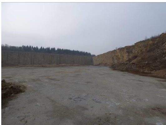
Abb. 14 Blick auf die Abbruchkante im Süden.
