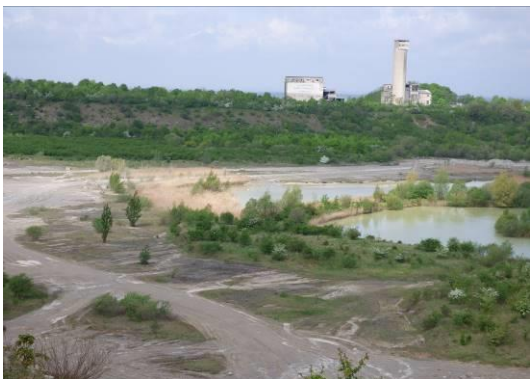
Abb. 22 Blick auf verwaiste Gebäude westlich des Betriebsgeländes.
