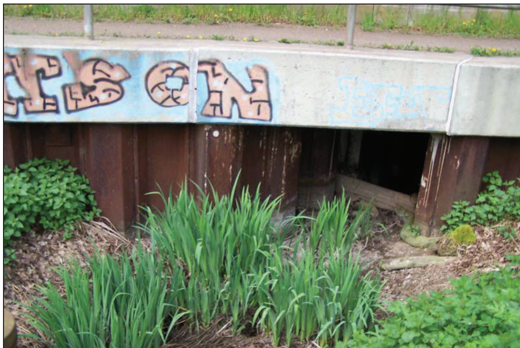
Abb. 4: Durchlass mit Sohlabsturz im Osten der A 57 bei Schloss Lauersfort
