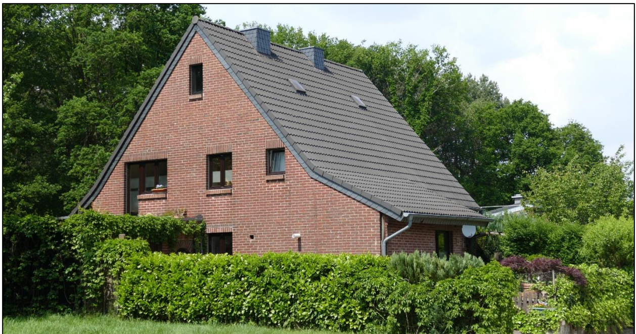
Abbildung 5: BP 1 ‚Krummer Weg 68‘ – Blickrichtung Nord
