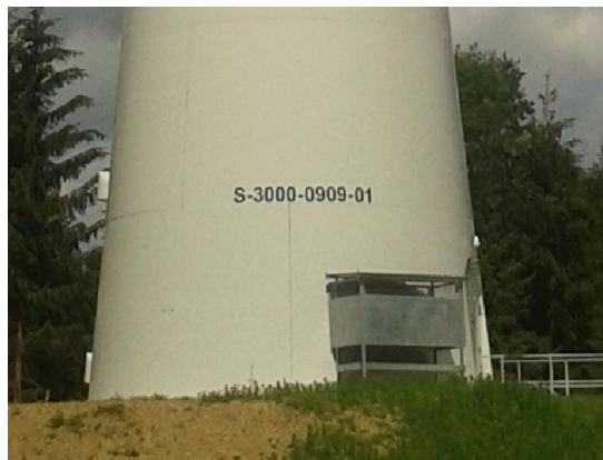
Abbildung 2: Beispielhafte WEA-NIS-Nummer an einer WEA.
