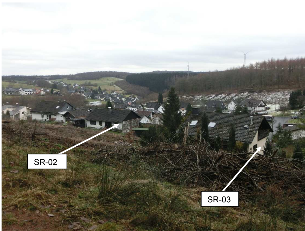
Bild 2: Schattenrezeptoren SR-02 und SR-03 von Nordwesten
