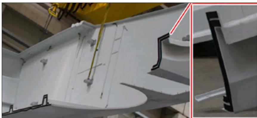
Abbildung 2 Detailansicht Gondelverklebung
