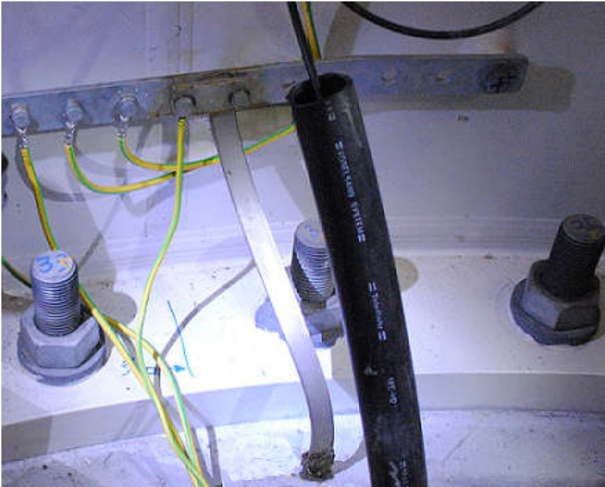
Abb. 10 - 1: Anschluss Potentialausgleichsschiene mit Erdungssystem – Stahlurm
