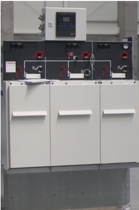
Abb. 5.2.2 - 1: Beispielhafte Anordnung einer MS-Schaltanlage (RMU-I-Konfiguration)
