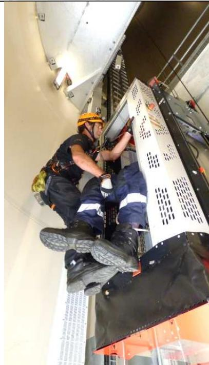
Der Retter löst das Seil aus der Bremse des MILAN um gleichzeitig mit einer Hand kontrolliert Seil nachzugeben und mit der zweiten Hand durch Zug an dessen rechter seitlicher Halteöse den Verunfallten über die Kante zu drehen.
