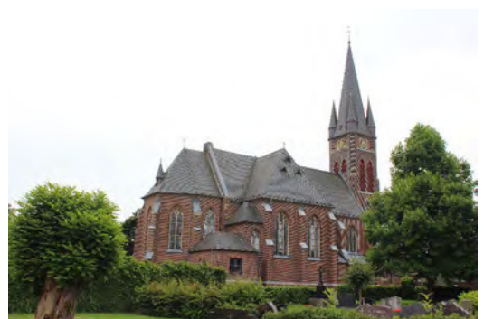
Blick aus nördlicher Richtung
