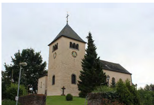
Blick aus nordöstlicher Richtung
