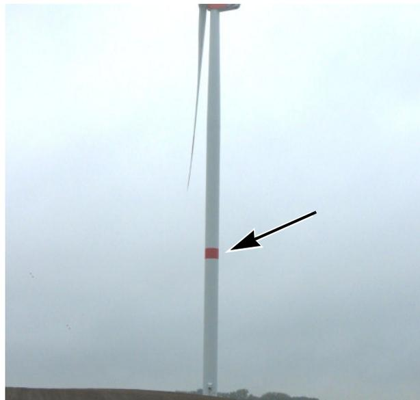
Abb. 4 Roter Farbring an Anlage mit Gesamthöhe >150 m
