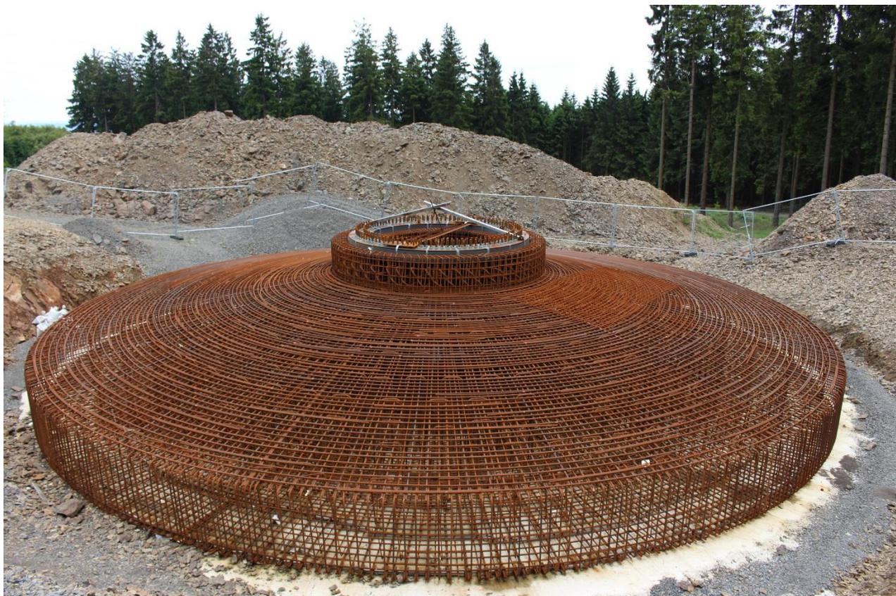
Abb. 1: Beispiel für den Bau eines Flachfundaments einer Windenergieanlage<sup>4</sup>
