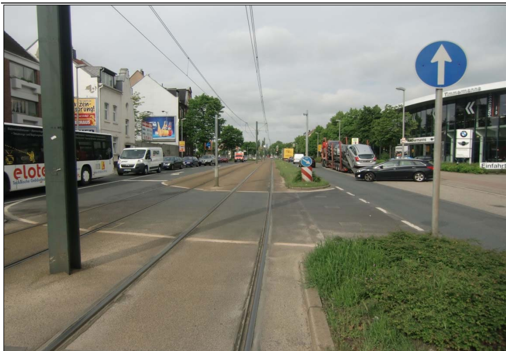
Abb.-Nr. 2: Heerdter Landstraße, Blickrichtung Westen
