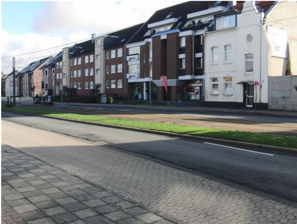
Foto 5: Blick auf die Bebauung an der Heerdter Landstraße, südlich Stadtbahn-Haltestelle
