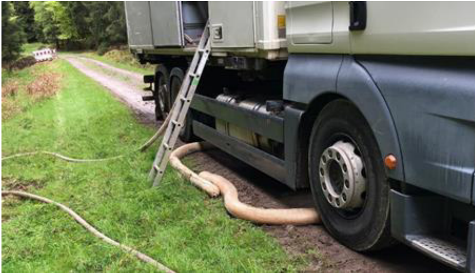
Abbildung 5: Empfohlene Maßnahme: Vorsorgliche Auslage von Sorb-Schlängeln unter Tanks, z.B. von Baufahrzeugen, wenn sie länger stehen
