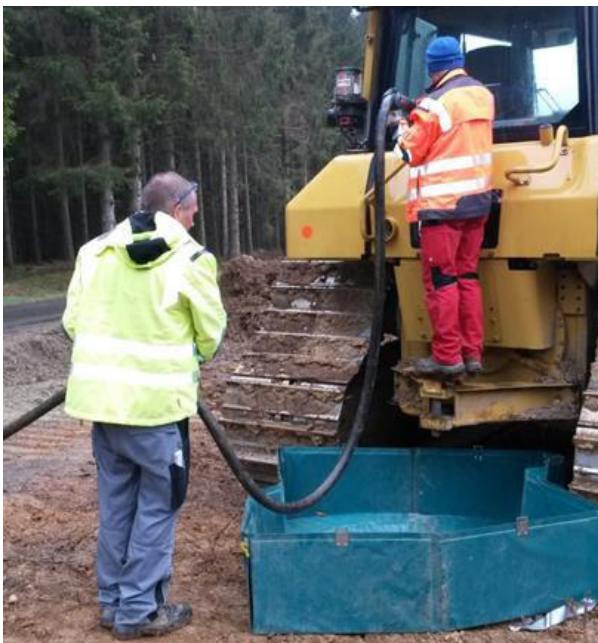
Abbildung 4: Empfohlene Maßnahme: Betankung der Baumaschinen im Baufeld von 2 Personen mit faltbarer Auffangwanne
