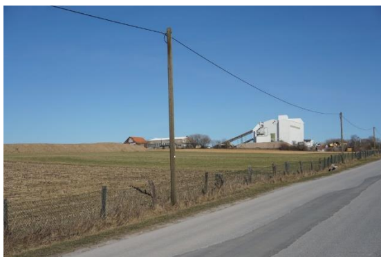
Abb. 7 Blick auf die Bestandsgebäude des Steinbruchs „Lohbusch“.
