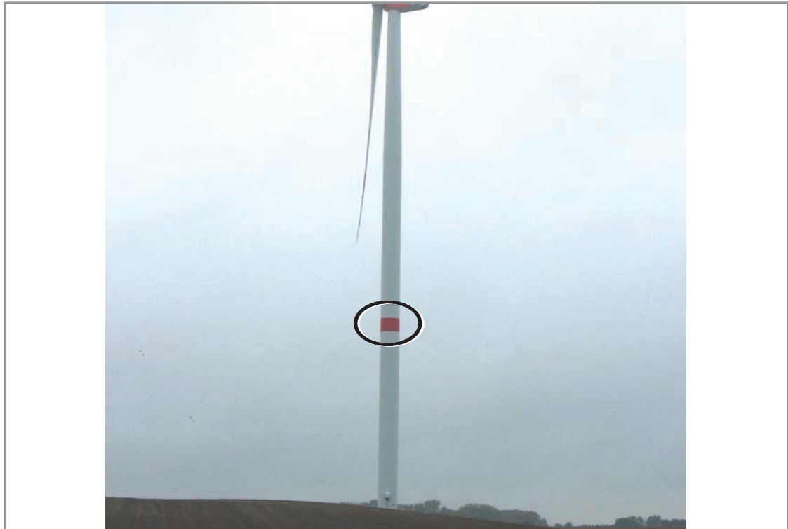
Abb. 5: Roter Farbring an Anlage mit Gesamthöhe >150 m
