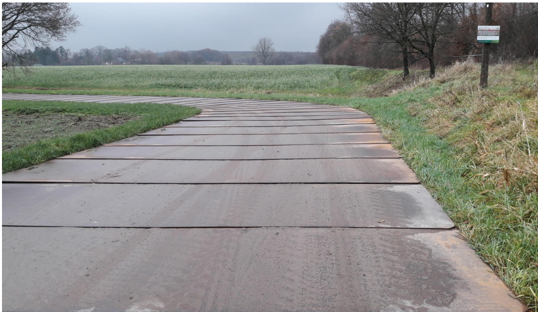
Abbildung 11: Stahlplattenbaustraße auf dem Oberboden
