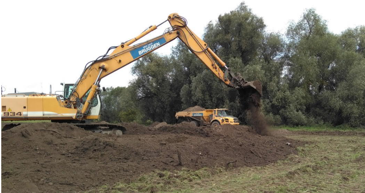
Abbildung 14: Oberbodenauftrag vor-Kopf mittels Kettenbagger
