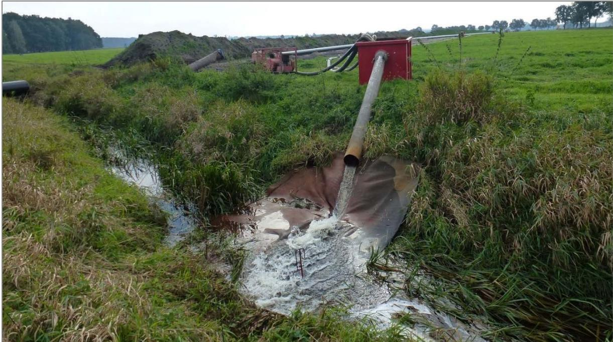
Abbildung 2: Bsp.: Einleitung in Oberflächengewässer mit Schutz vor hydraulischer Belastung
