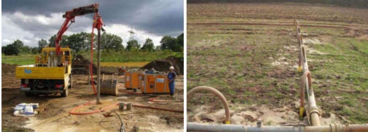
Abbildung 1: Einrichtung der Wasserhaltung mittels Spüllanzen (IFUA, 2021b)
