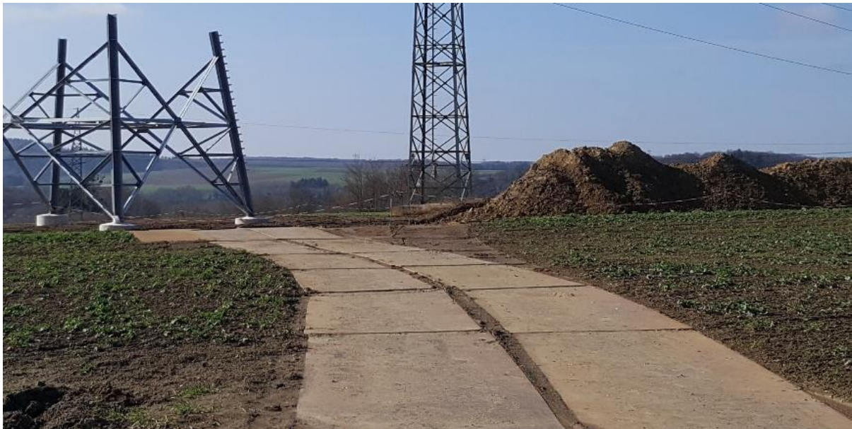
Abbildung 1: Temporäre Zuwegung über Fahrbohlen, hier mit Stahlplatten
