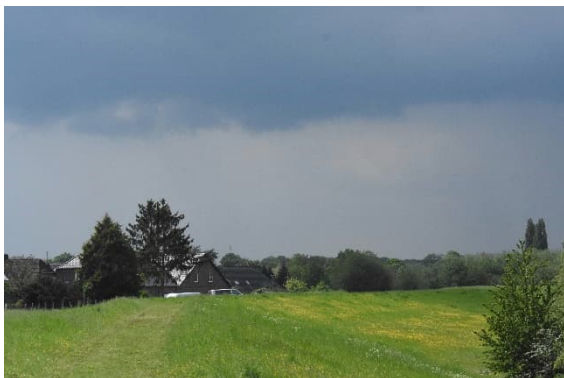
Abb. 9: Deichanlage östlich von Birten
