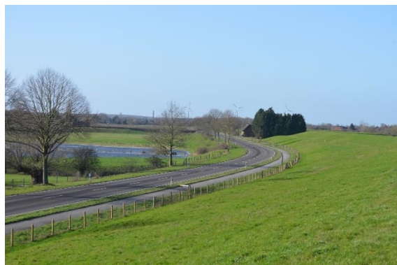
Abb. 8: Weseler Straße südlich entlang des Deiches
