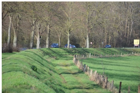
Abb. 10: Angeschüttete Spundwand entlang der Rheinberger Straße
