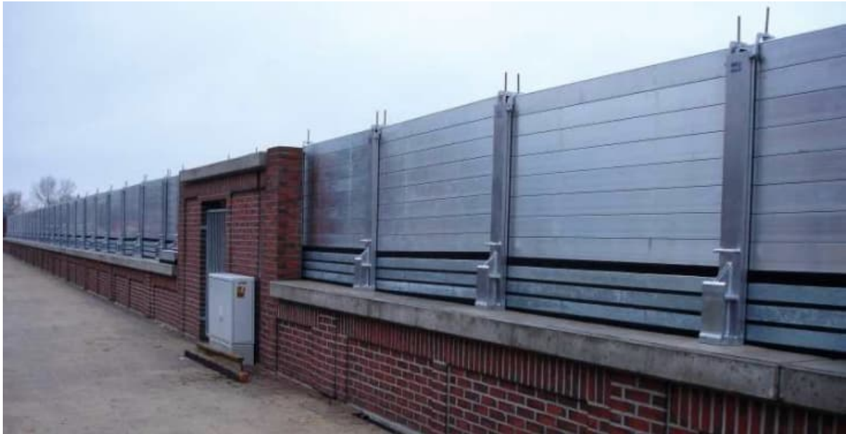
Abb. 7: Hochwasserschutzwand durch Stahlbetonmauer mit Dammbalkensystem
