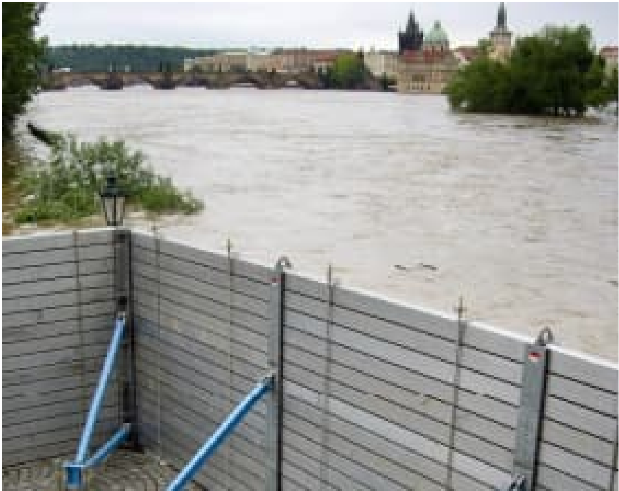
Abb. 8: Hochwasserschutzwand durch mobiles Dammbalkensystem
