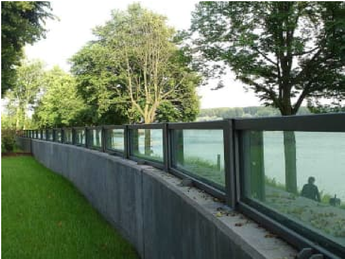
Abb. 6: Hochwasserschutzwand mit Glaselementen
