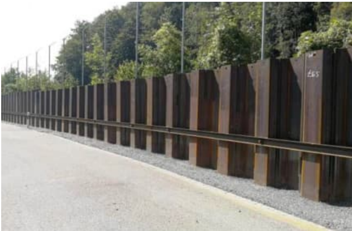
Abb. 5: Hochwasserschutzmauer aus Spundwandprofilen
