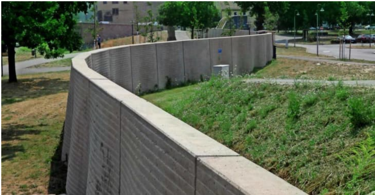
Abb. 4: Hochwasserschutzmauer aus Stahlbeton
