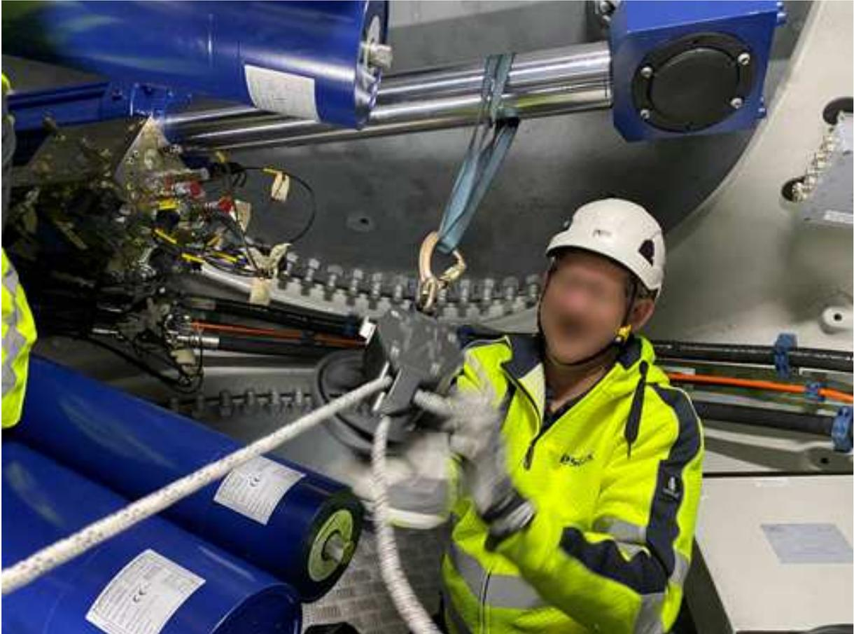
Abbildung 7.27: Befestigung der Notabstiegsvorrichtung am Pitchzylinder
